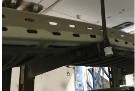
Bild 5: Rinnenmontage auf Ausleger Typ AW 15 41 und Anschlussbauteil AB AW 15
