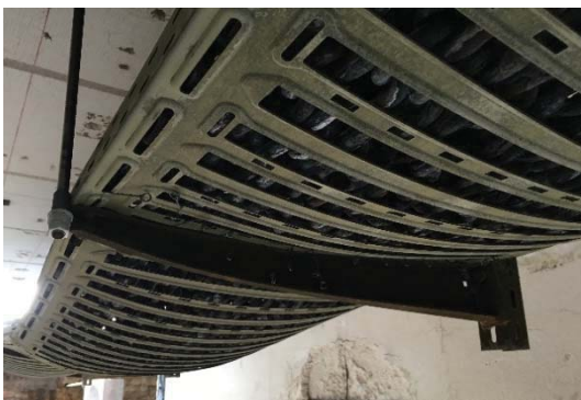
Bild 1: Kabelträgersystem nach der Prüfung
