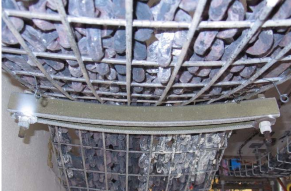
Bild 4: Gitterinnenmontage auf Schienen
